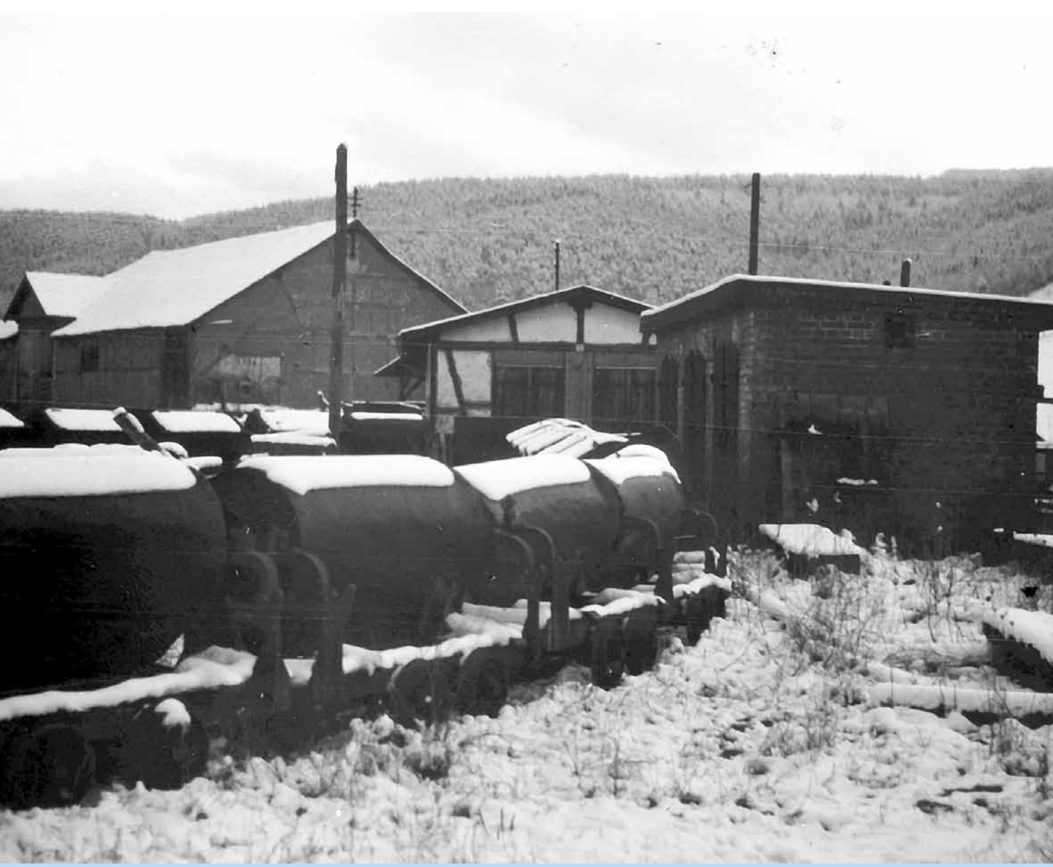
In der Bildmitte ist die Giebelseite des heute nicht mehr vorhandenen Lokschuppens zu sehen. Hier waren die beiden Benzlokomotiven untergebracht. Rechts daneben steht das Gebäude, in dem das Benzol für die Lokomotiven lagerte. Im Vordergrund sieht man einige der 77 Loren, die im Bertha-Stollen zur Streckenförderung eingesetzt wurden.
