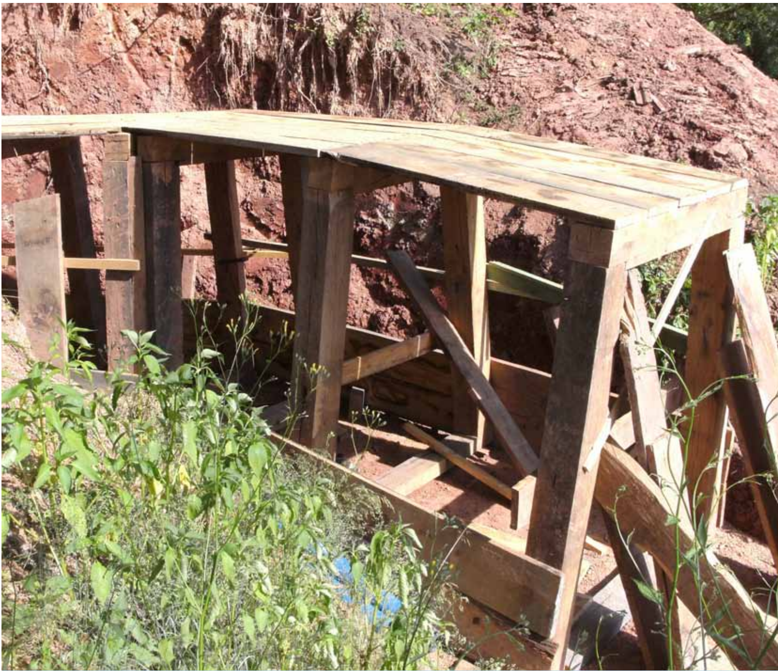
Zimmerarbeiten am rekonstruierten Bertha-Stollen (2013)
