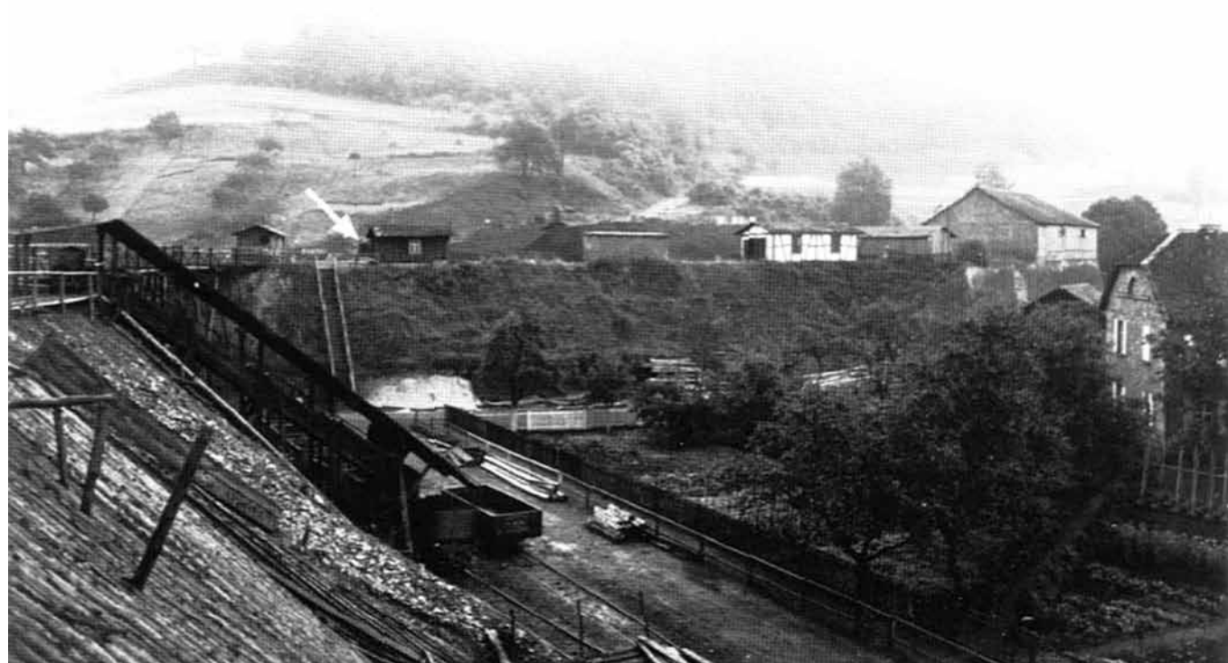
Anschluss Schmelz; links die Erzrutsche mit den darunter stehenden Waggons.
