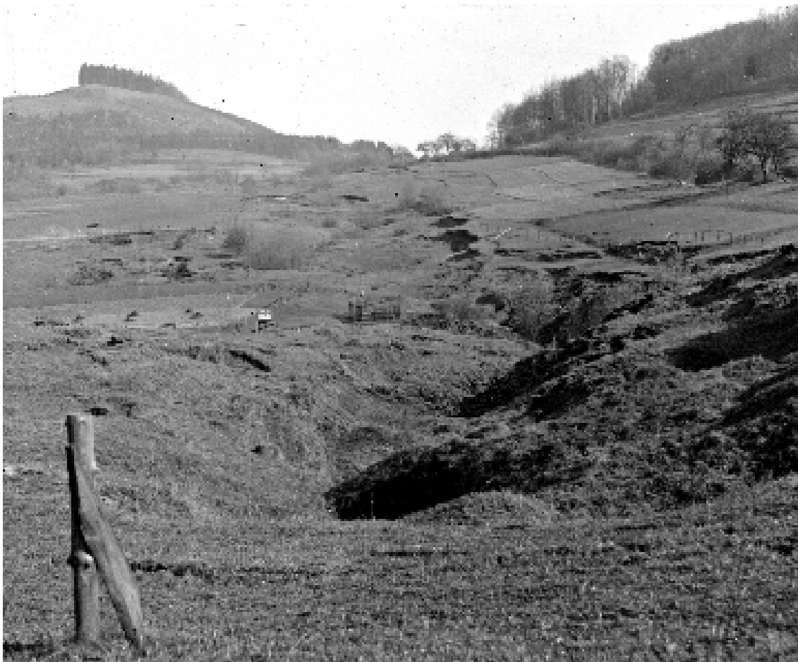
Blick auf den Burgberg von Bieber um 1920; gut zu erkennen sind die Pingen, die sich durch das Einstürzen alter Stollen gebildet haben.
